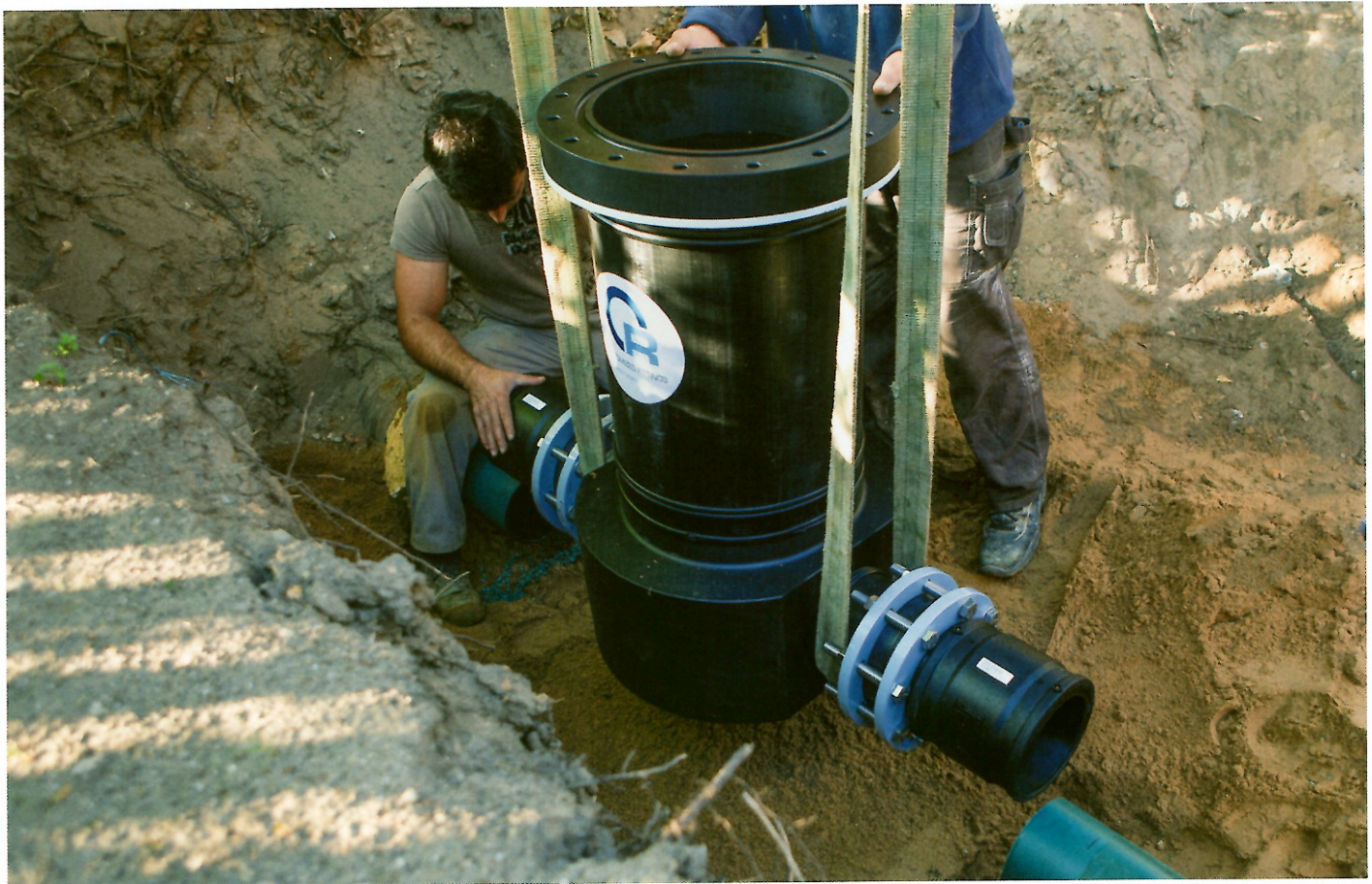
Einbau der Molchschleuse „Quick-Pig“ in vorhandene Abwasserdruckleitung d 180 mm SDR 17
