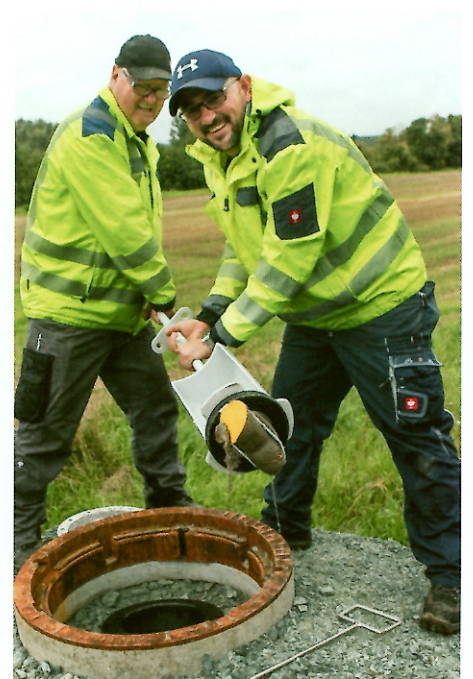
Am Ende der 1.200 m langen Molchstrecke dient eine Molchstation Quick-Pig als Molchempfänger. Der Zustand des Test-Molches und die Verunreinigungsbestandteile geben Aufschluss über das Molchergebnis: Eine Molchfahrt mit dem Reinigungsmolch kann umgehend erfolgen.
