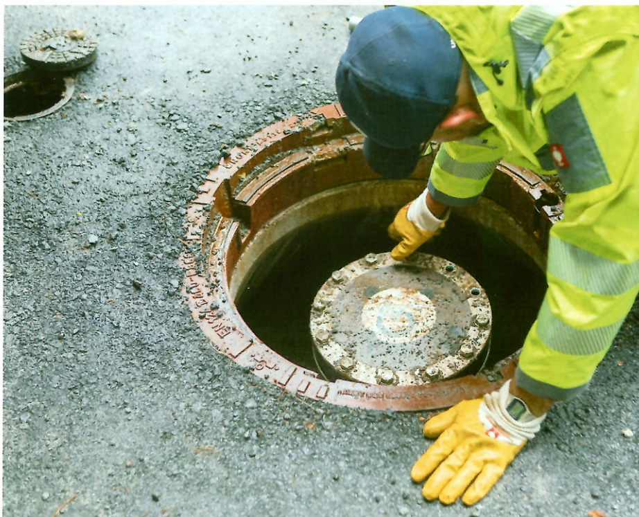
Vorbereitung der Molchung über Molchschleuse Quick-Pig d 75 mm SDR 11 beim ZLS Lollar, hier: Sendestation | Fotos: Reinert Ritz GmbH
