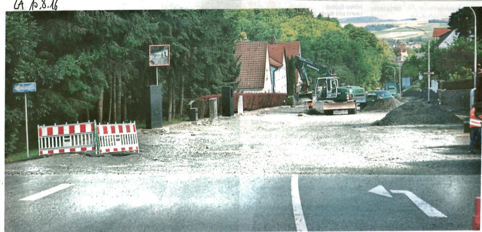
Auf rund 760 Metern erhält die Vogelsbergstraße in der Ortsdurchfahrt Blitzenrod einen neuen Aufbau.
