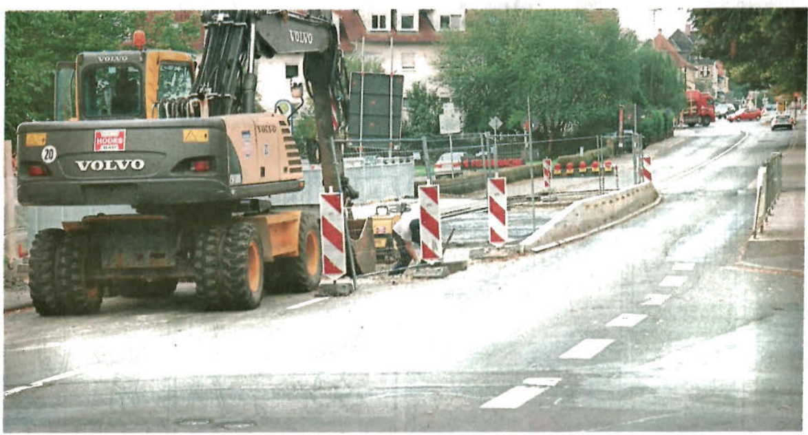
Die Instandsetzungsarbeiten an der „Brennerwasserbrücke“ kommen gut voran.
