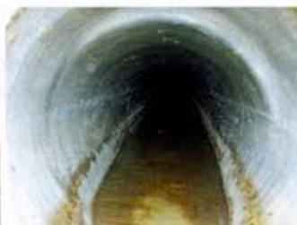
... und nach der Sanierung durch einen GFK-Schlauchliner.
