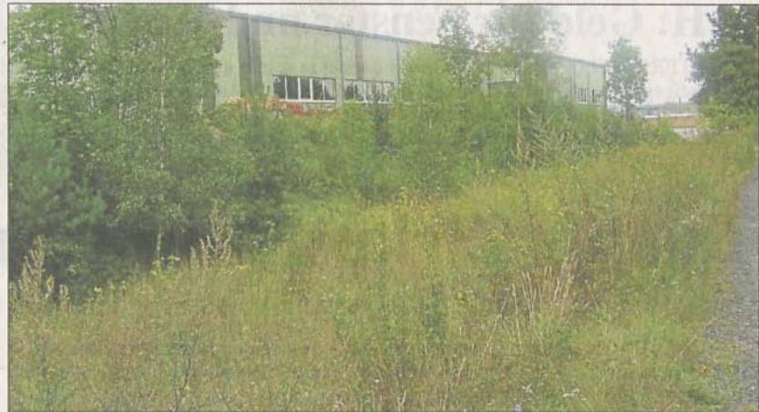
Auf dem ehemaligen Bahngleis der Vogelsbergbahn wird zwischen Rimloser und Altebergstraße eine Entlastungsstraße gebaut und der Bereich des ehemaligen Südbahnhofes neu gepflastert. Es entstehen außerdem Grünanlagen und neue Parkplätze.
