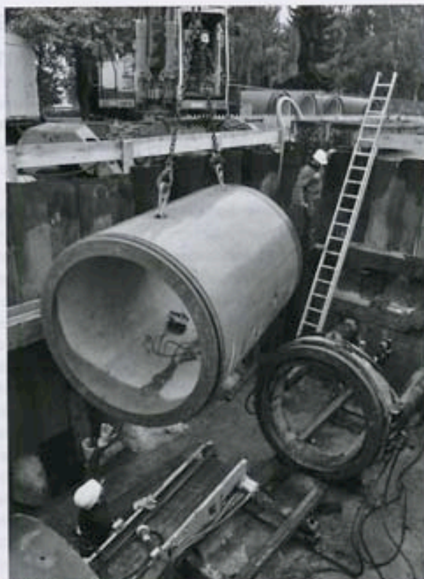
Einheben eines Stahlbetonrohres
