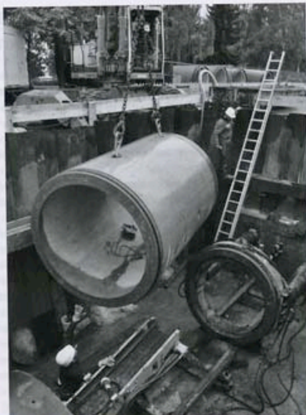
Einheben eines Stahlbetonrohres
