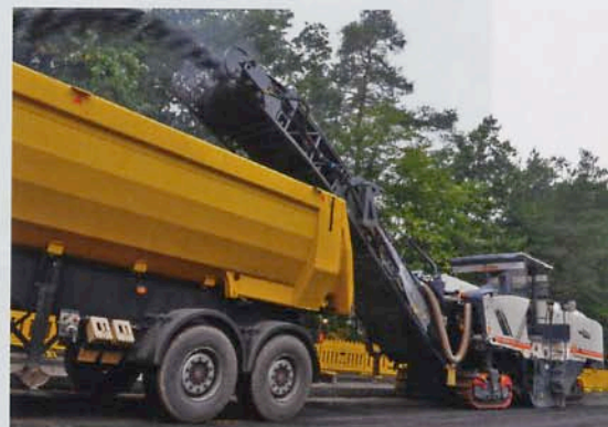
„High Tech“ auch oberirdisch: Dieser Prototyp einer Asphaltfräse von Wirtgen, auf der Licher Straße im Testeinsatz, fräst ganze Fahrbahnen von 2,10 m Breite auf einmal ab Fotos: Ohlsen
