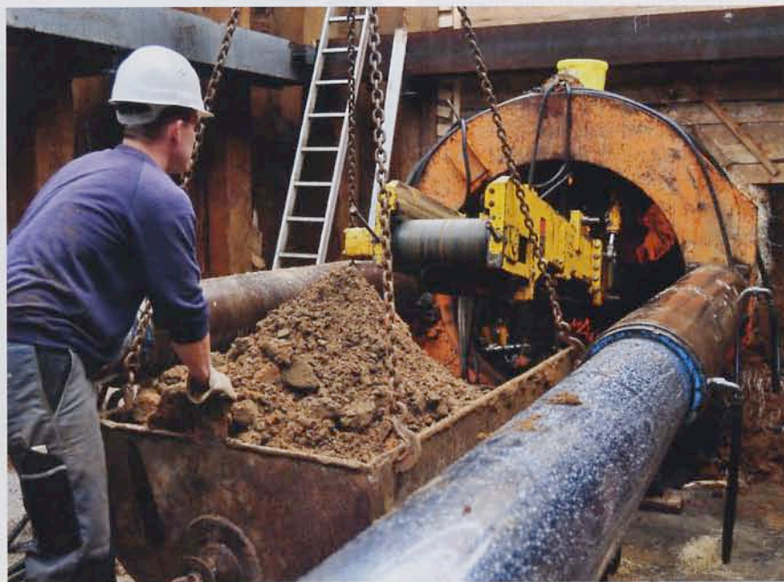
Das an der Ortsbrust abgebaute Erdreich wurde per Fließband kontinuierlich nach hinten gefördert
