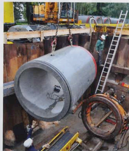
Sieben Tonnen im Schwebezustand: Einbau von einem der sechs Stahlbetonrohre, die unter der Vogelsberg-Bahn hindurch gepresst wurden
