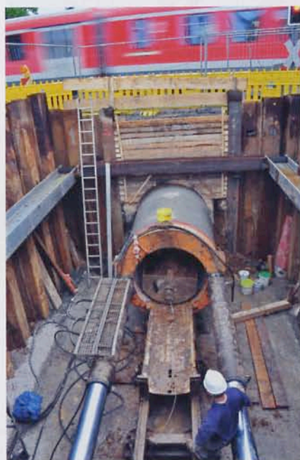
Minimale Überdeckung, intensiver Bahnverkehr: Schwierige Randbedingungen, die jedoch binnen fünf Tagen souverän bewältigt wurden
