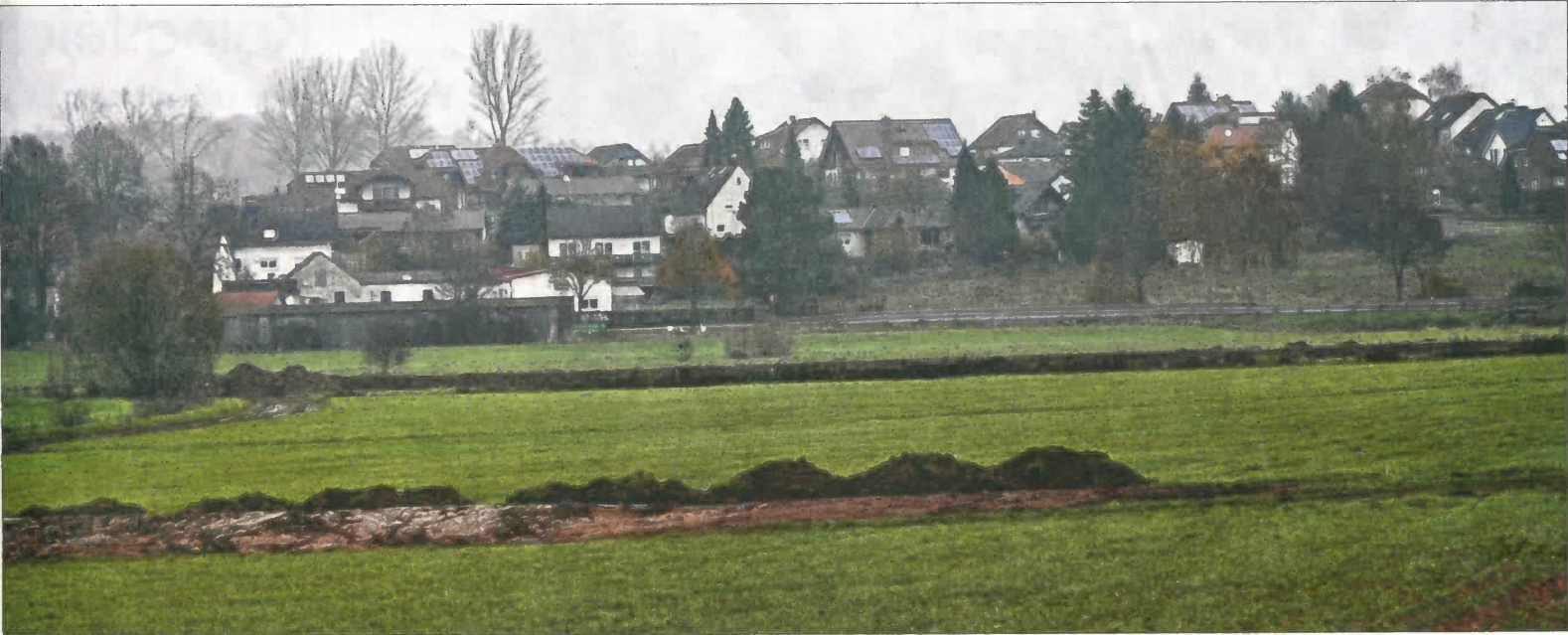
Vorlandwallungen vor Stockhausen: Mit solchen rechtwinklig zum Bachverlauf angeordneten Dämmen soll die Hochwassergefahr im unteren Seenbachtal vermindert werden. (Fotos: tb)
