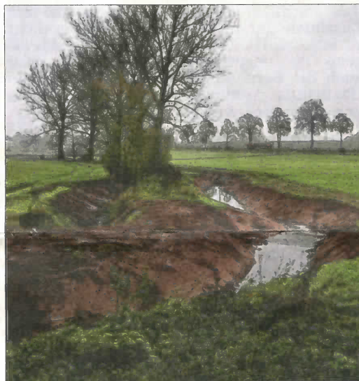
Neu angelegte Flussschlinge (Mäander) mit Nebenarm in der Gemarkung Seenbrücke.
