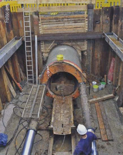
Neue Rohre unter Grünbergs Bahnhofstraße. Geplant sind die Arbeiten vom ortsansässigen Ingenieurbüro Ohlsen.
